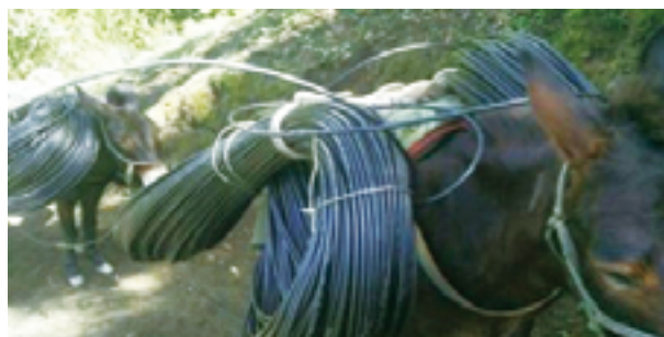
2015 年 6 月 25 日，中国电信在西藏自治区林芝地区墨脱县甘登乡为乡通光缆工程运输物资
