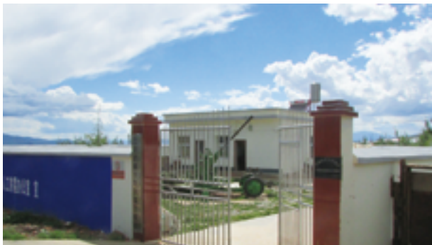
中国电信 2015 年援助四川省盐源县建成卫城镇东关村防雷作业点
