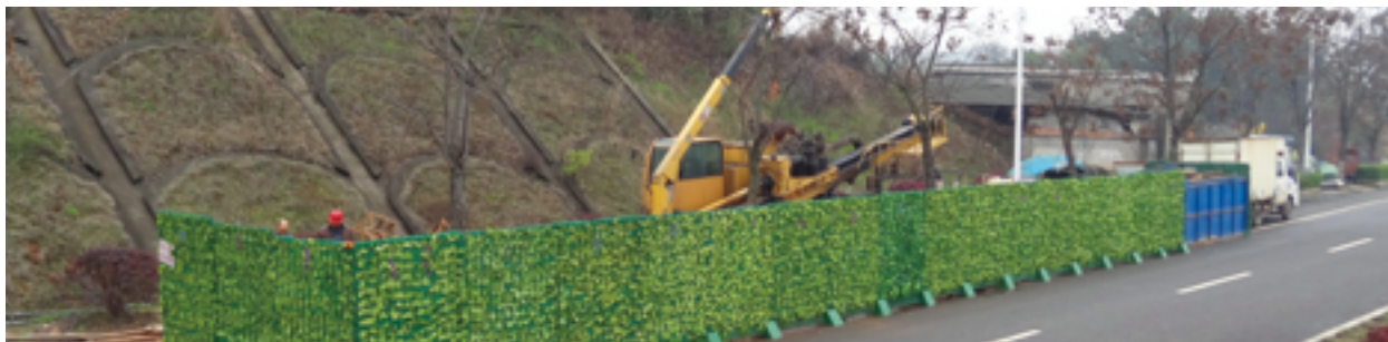
2015年3月20日，湖南省通信建设有限公司下属的株洲市分公司4G配套光缆顶管工程施工现场
