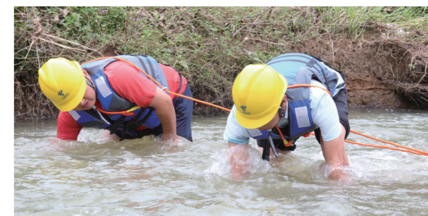
2020 年 7 月 16 日，江西省九江市湖口分局工作人员在都昌马洞桥河附近摸排河底光缆，确保干线安全
