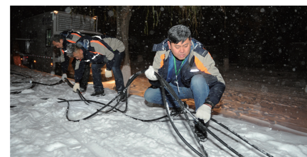
2020 年 11 月 18 日起，受极端雨雪冰冻天气影响，吉林省部分地区停电停水停热停运，吉林省公司迅速响应，恢复受灾地区通信服务
