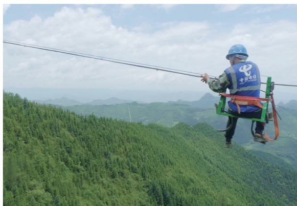
2020 年 5 月 28 日，工作人员在广西壮族自治区河池市罗城县兼爱乡旦兴村肯桥屯 4G 基站架设连接基站的光纤通信线路
