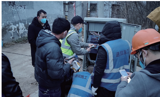
2020年2月10日，陕西公司工作人员进行基站光缆熔接，抢通陕西高陵防疫医院无线网，全力保障西安市公共卫生中心4座基站按时开通，为医院提供通信及信息化服务
