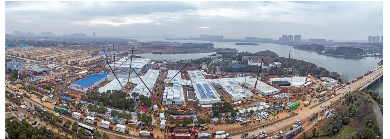
2020年1月31日，“天翼云监工”云上近景直击武汉火神山医院、雷神山医院建设施工
