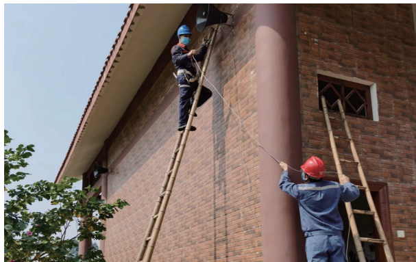
广西公司在广西壮族自治区南宁市武鸣区推广“天翼大喇叭”覆盖 1220 个自然村，共 70 万农村居民，有力保障疫情防控信息的传递。图为 2020 年 3 月 9 日，装维员工正在双桥镇八桥村大伍屯安装“天翼大喇叭”
