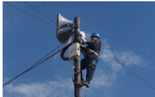
2020 年 7 月 20 日，新疆公司员工在哈密市伊吾县前山乡塔拉布拉克村安装“天翼大喇叭”，5 天完成哈密市伊吾县 28 对大喇叭的安装调测，实现偏远地区的信息覆盖
